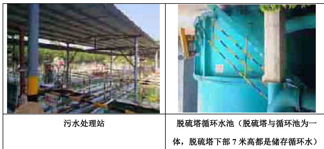
图 4.1-1 项目废水污染防治设施图
