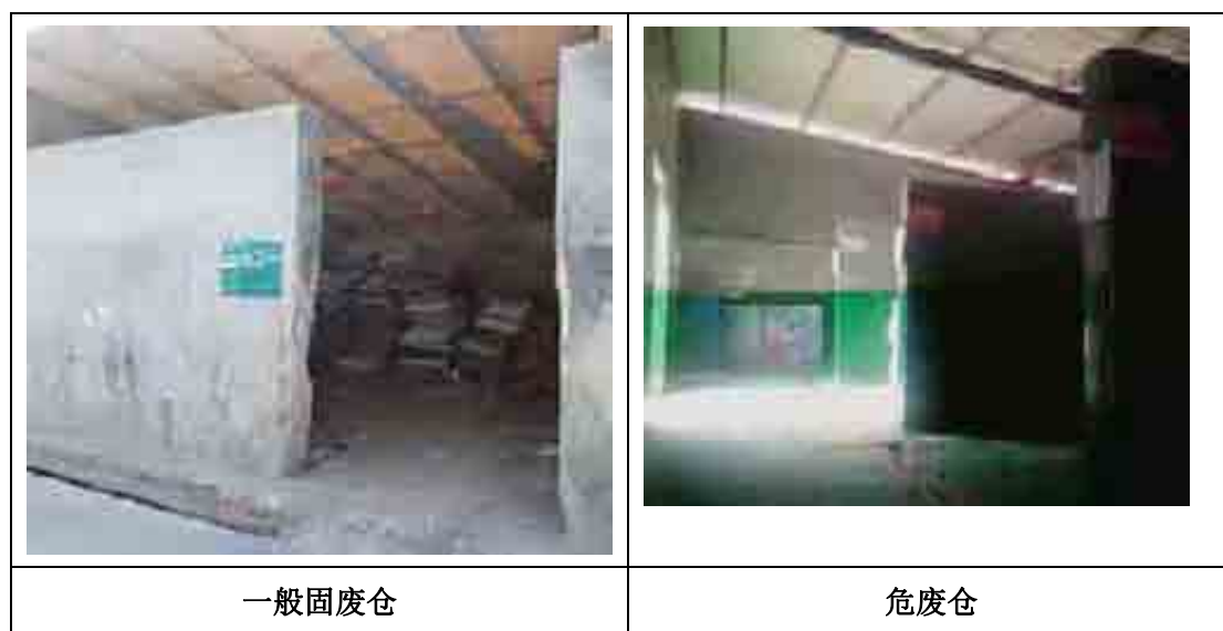
图 4.1-4 固体废物暂存仓
